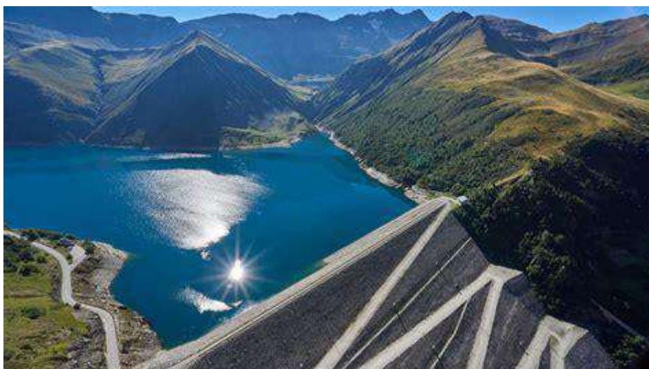
Vue aérienne du barrage de Grand'Maison en Isère, le plus grand de France.
